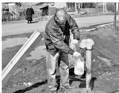
Водопроводная колонка у переезда
