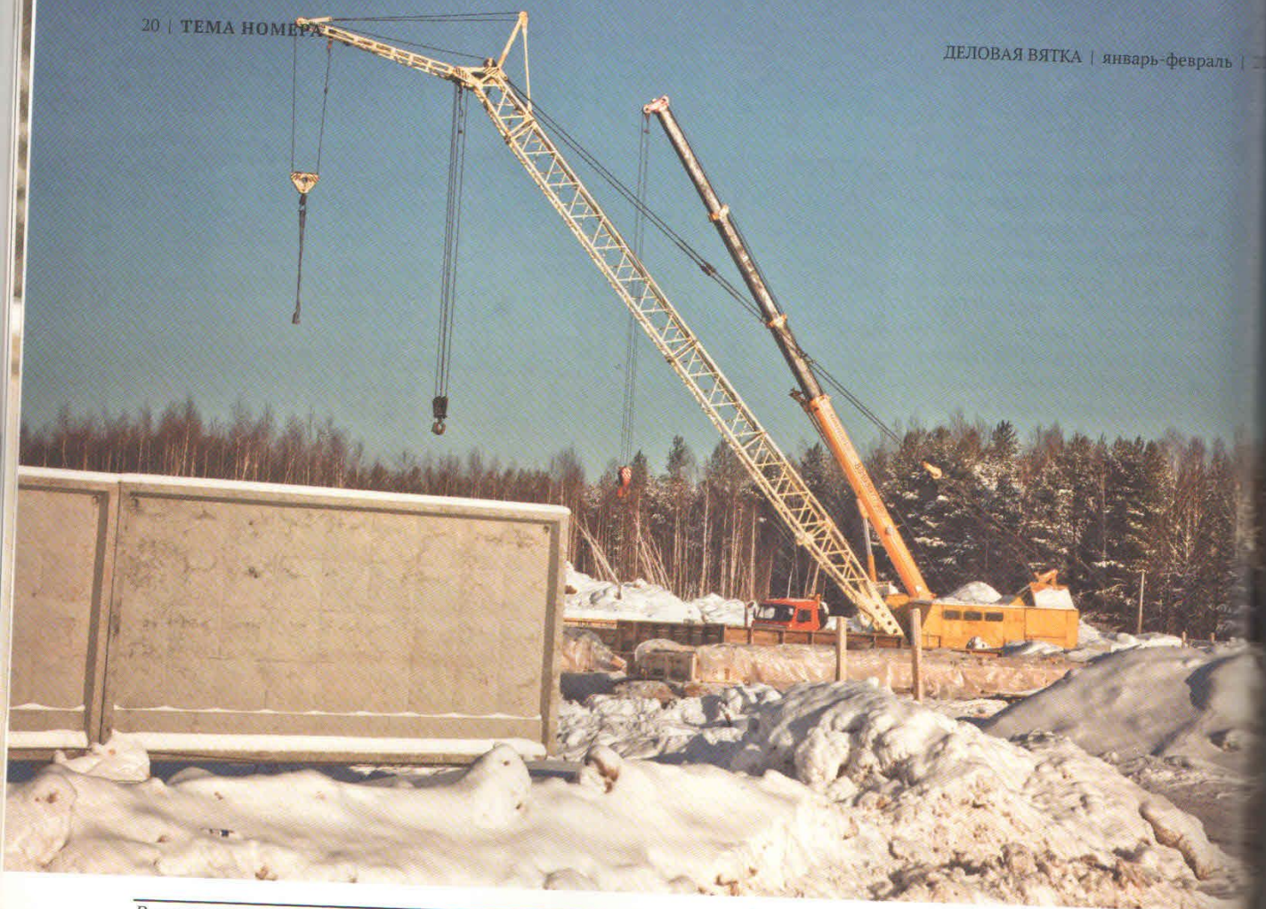
Рядом с деревней Кочкино ведется строительство подстанции «Речная» по водоводу «Кумёны – Киров»
